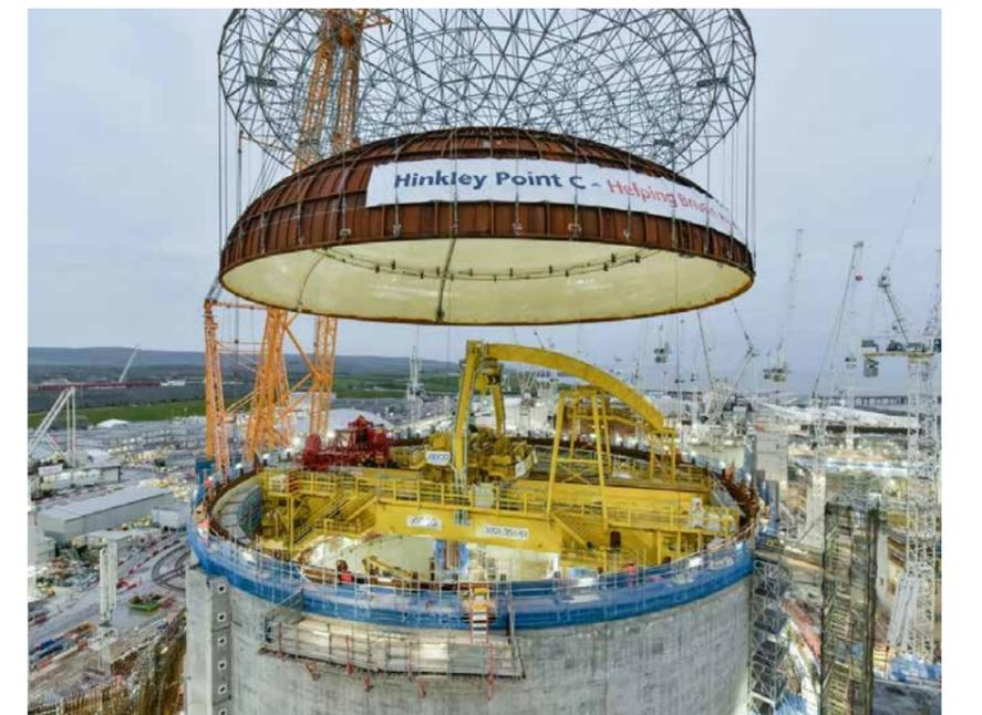
Figure 4 : pose du dome sur le projet HPC au Royaume Uni (copyright EDF Energy)
