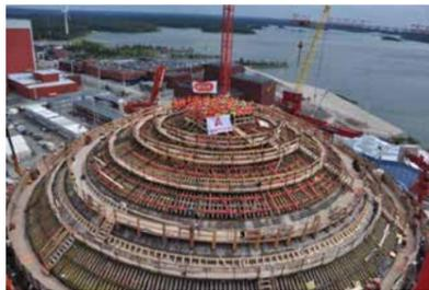
Figure 1 : Fin des travaux du dome sur l'EPR Finlande
