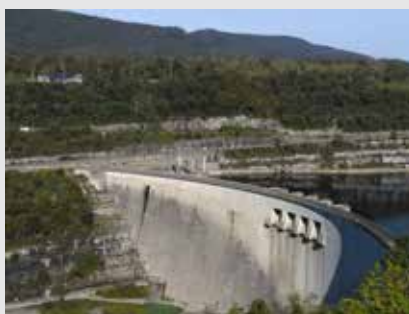
Le barrage de Vouglans
